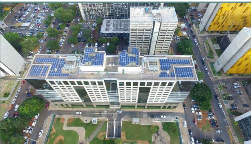
Projeto: CEF - Matriz II Potência: 69,96 kWp Nº de placas: 264
