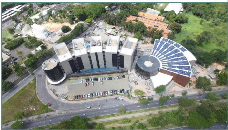
Projeto: FAPEMIG Potência: 157,15 kWp Nº de placas: 593
